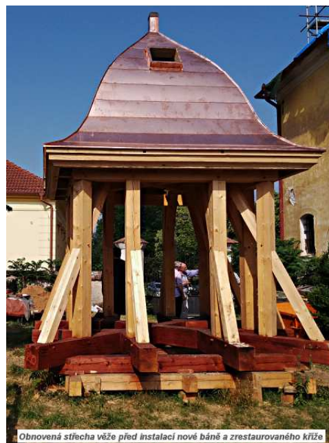
Obnovená střecha věže před instalací nové bány a zrestaurovaného kříže
