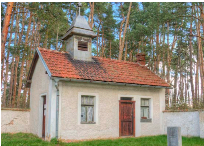
Márnice na hřbitově při silnici na Pečky
